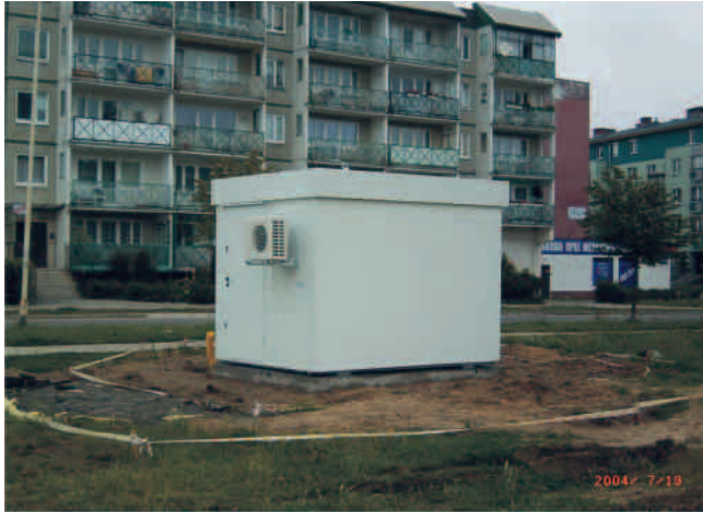
Szczecin, ul. Andrzejewskiego (os. Majowe) Szczecin, Andrzejewskiego Str. (Majowe residential area)
