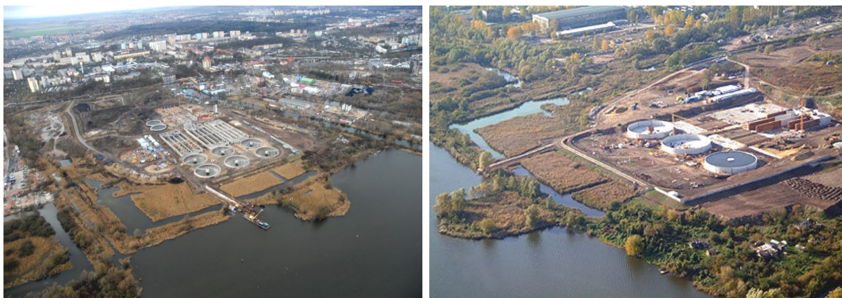
Fotografia IV.1.1. Plac budowy oczyszczalni ścieków Pomorzany (źródło: ZWIK)
