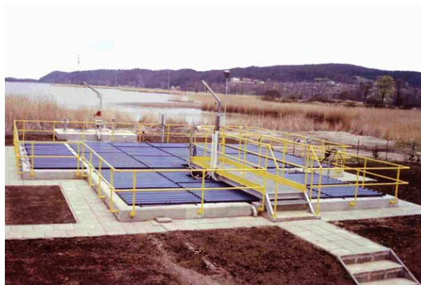
Reaktor biologiczny automatycznej oczyszczalni ścieków w Wapnicy
